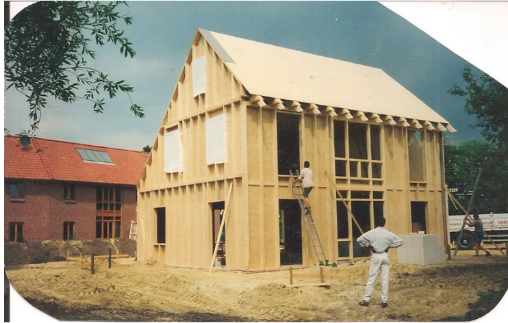
Das Hausgerüst steht
