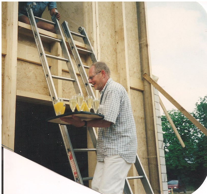
Auch zu den Dachdeckern nach oben kommen die Sektgläser. Ubbo ist keine Leiter zu steil!
