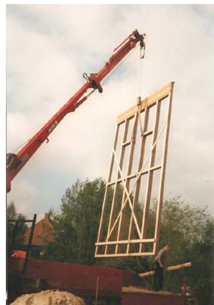
Das Gerüst hängt am Haken des Krans
