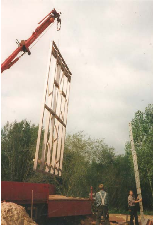
Das Gerüst wird herabgelassen ...
