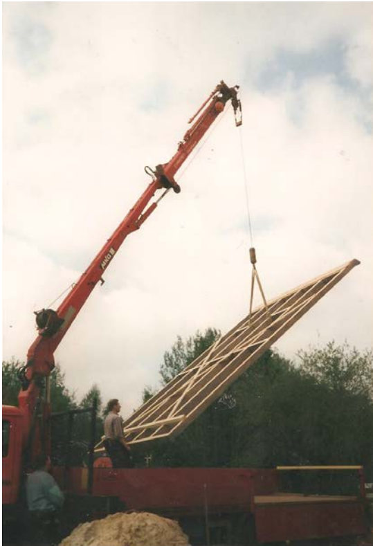
Das Gerüst hängt am Haken des Krans
