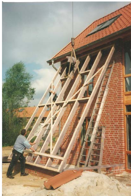
... und auf die auf der Umfassungsmauer ruhenden Schwellenbalken aufgesetzt.
