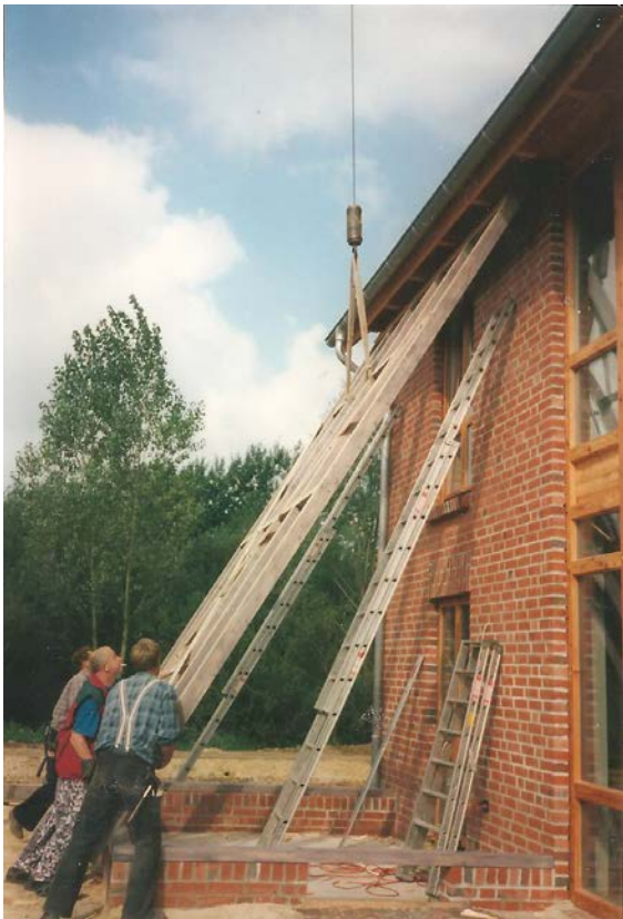
... und auf die auf der Umfassungsmauer ruhenden Schwellenbalken aufgesetzt.
