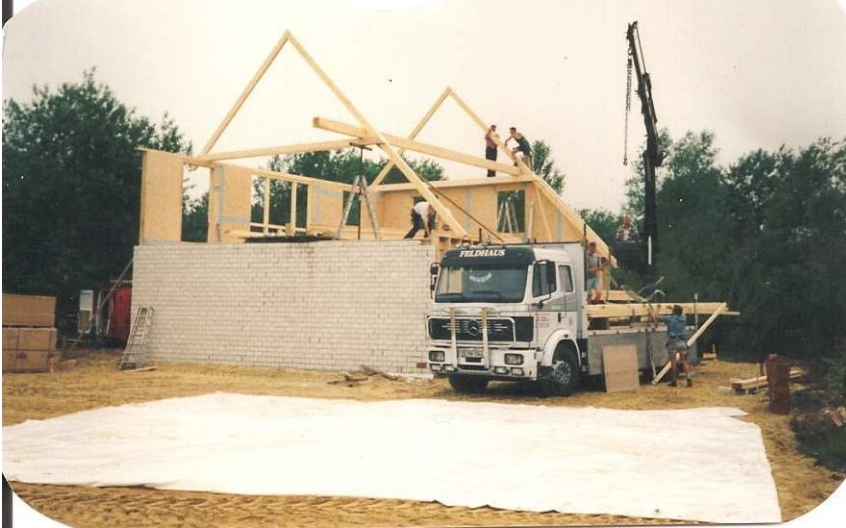
Freitag, 13.06.1997, 09:00 Uhr: Baustelle (heute: Alte Ziegelei 4)
