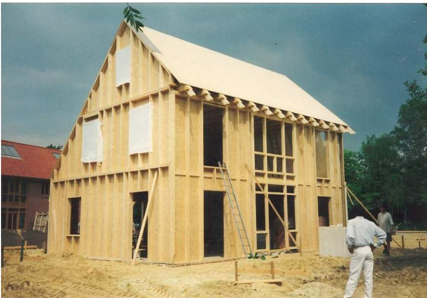
Freitag, 13.06.1997, 14:00 Uhr: Baustelle (heute: Alte Ziegelei 4)
