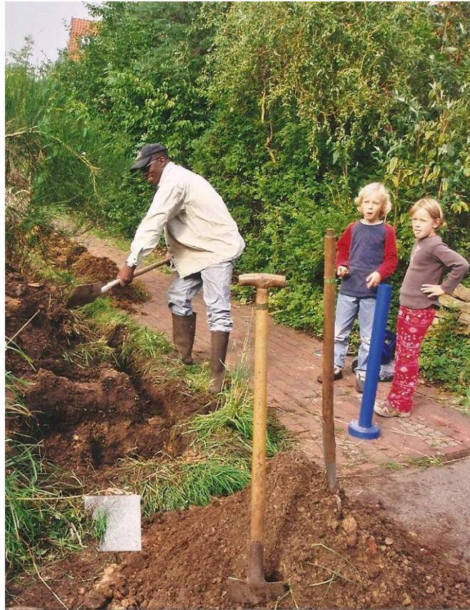
26.08.2005: Lampe an der Ecke vom Biotop und Spielplatz Für die Stromleitung vom Verteilerkasten an der Brücke wird eine Furche gehoben: Ben Khumalo-Seegelken mit Joshua und Joelle Kannapin.
